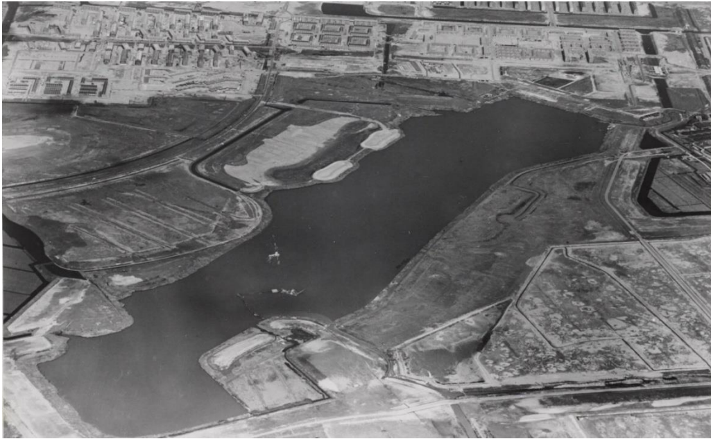
Afb. 13. Luchtfoto Sloterpark uit 1954. De polder werd ontgraven en de oeverlijnen van de plas ontstonden. Bron: 010009016588, 20 april 1954
