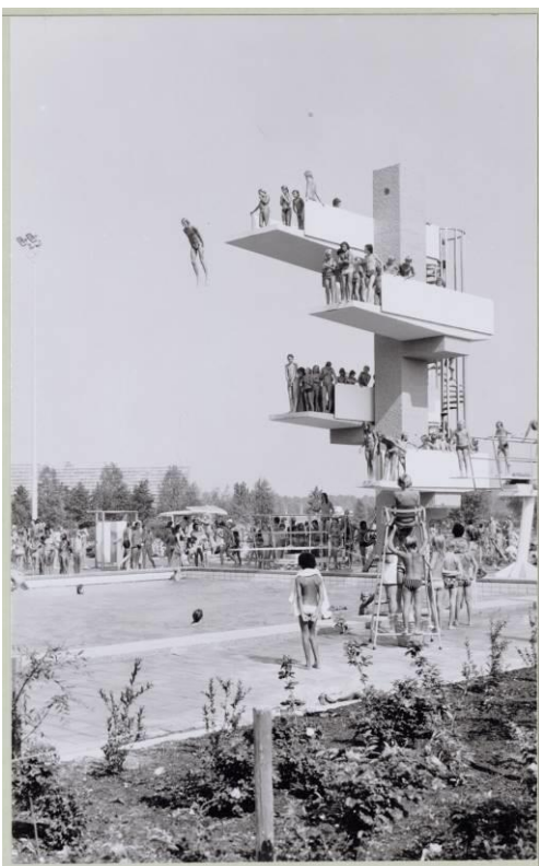
Afb. 22. De springtoren van het buitenbad op het terrein van het strandbad. Bron: SAA B00000013659, 197
